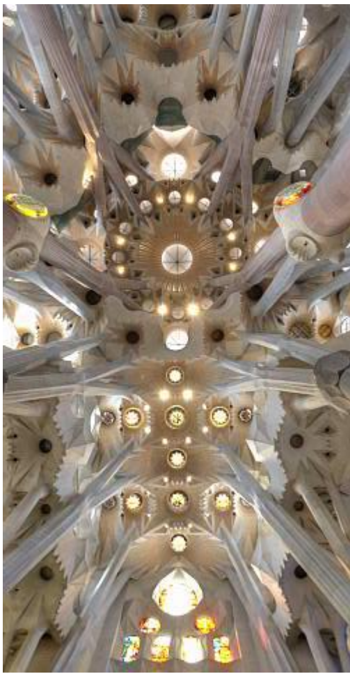
Hvælvingen i La Sagrada Família. Det skulle være en hyperbolsk paraboloid.
